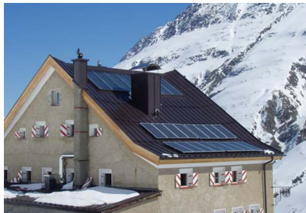
Photovoltaik 3 kW thermische Solaranlage 16 m 2
